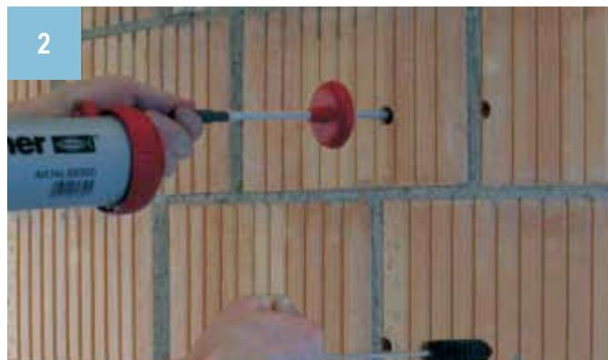
Les trous forés doivent être soigneusement nettoyés pour éliminer la poussière due au forage. Procédure de nettoyage :
