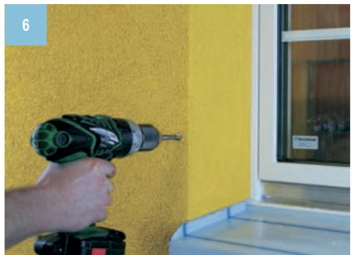
6) Tailler un filetage dans le panneau compact et la plaque en aluminium.
