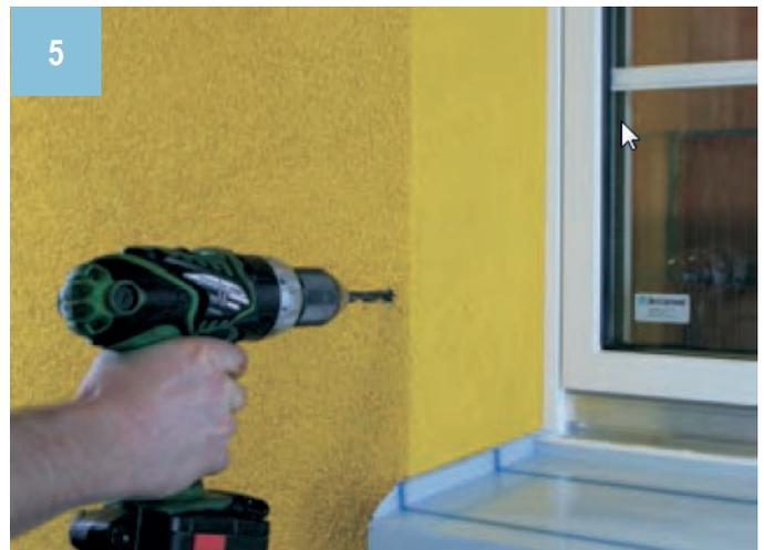
5) Percer un trou à travers le panneau compact et la plaque en aluminium. La profondeur de perçage doit être de 36 – 46 mm.
