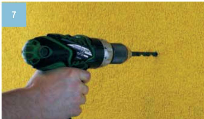
La façade doit être terminée et séchée avant la fixation des charges. Visser les éléments dans les blocs de montage universels à l'aide de vis à tôle ou vis M. Les vis à bois et les vis autoforantes ne conviennent pas. La profondeur du trou de forage doit être de min. 40-50 mm.
