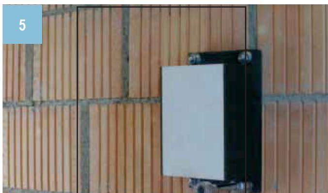
Lors du montage, serrer l'écrou jusqu'à ce que le bloc de montage soit à fleur avec les plaques isolantes et entièrement insérée dans le mortier de collage. Après le durcissement du mortier de collage, serrer une dernière fois les écrous.
