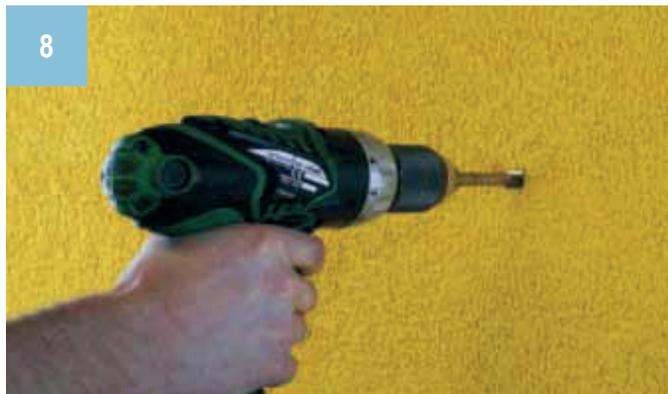
Dans le cas de vis M, il convient de procéder à un filetage à travers la plaque en résine phénolique ou en aluminium. Le filetage n'est pas nécessaire dans le cas de vis à tôle.
