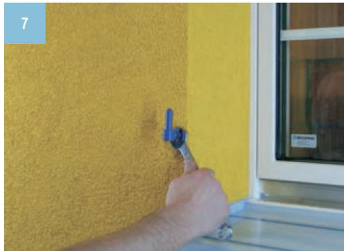
7) Visser l'objet à monter dans la plaque de fixation.
