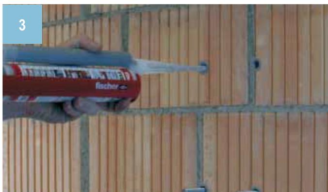
Insérer le mortier d'injection d'arrière en avant en le pressant. Insérer, le cas échéant, les tamis plastiques préalablement dans le trou. Dans le cas de maçonneries en blocs creux, utiliser obligatoirement des tamis plastiques pour injection. Insérer les tiges filetées à la main en effectuant un mouvement rotatif et laisser durcir le mortier d'injection. Consommation par bloc de montage Knauf Alu TRI :
