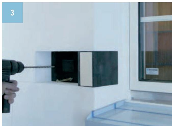
3) Effectuer la fixation mécanique seulement après le durcissement du mortier de collage. Contrôler la compatibilité des éléments de vissage fournis avec le support en présence. Dans le cas de maçonneries en blocs creux, forer sans percussion.
