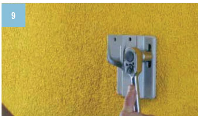
Visser la charge au bloc de montage universel Knauf Alu TRI. La profondeur d'ancrage doit être de min. 30 mm et se faire entièrement dans la plaque en alu noyée dans la mousse.
