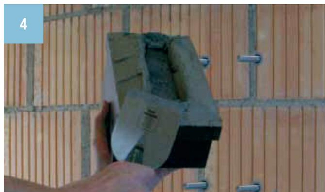
Après le durcissement complet du mortier d'injection des ancres, coller le bloc de montage Knauf universel sur le support en appliquant le mortier de collage, p.ex. Knauf SupraCem PRO sur toute la surface. Consommation par bloc de montage avec une épaisseur de couche de 5 mm : env. 0,29 kg.
