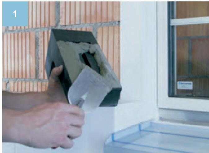
1) Il est recommandé de poser les plaques en même temps que le collage des panneaux d'isolation. Étaler du mortier adhésif sur la surface de collage de la plaque. L'élément doit être collé sur toute la surface du support.
