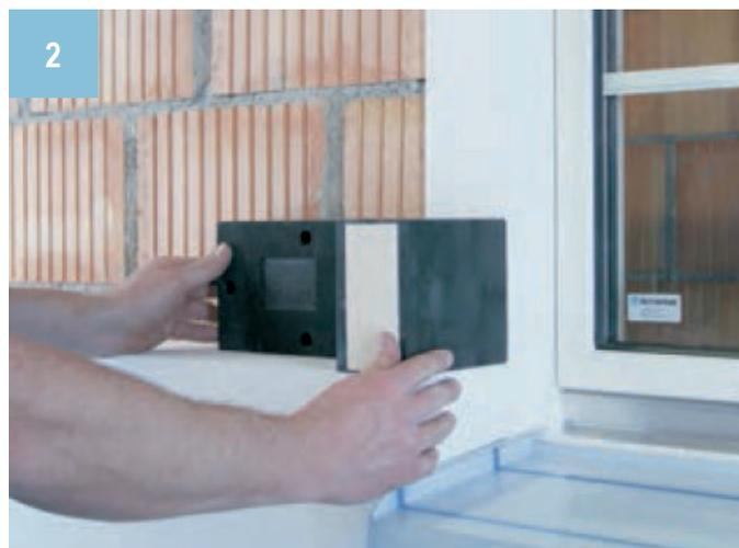
2) Presser la plaque à fleur des panneaux isolants. Le débord de la plaque pour battées ne doit pas dépasser 80 mm.
