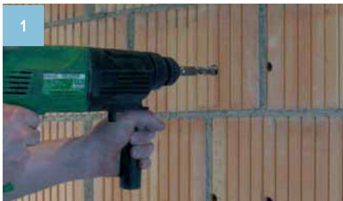
Poser les blocs de montage universels Alu TRI avant le collage des panneaux isolants. Marquer les points de fixation du bloc de montage universel sur le support et forer les trous pour la fixation. En présence de blocs creux, forer sans percussion. La profondeur de forage dépend du support et du type de fixation choisi.
