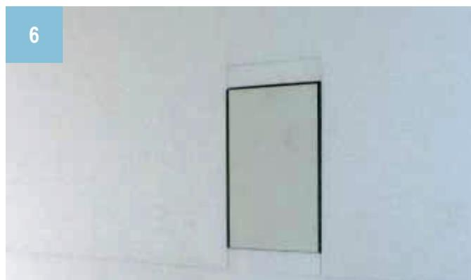
Adapter les plaques isolantes au bloc de montage universel sans créer de joints. Repérer l'emplacement exact des blocs de montage avant la pose du mortier d'armature ou fixer une vis à tôle comme marquage de manière à pouvoir retrouver aisément les blocs de montage après le parachèvement de la surface de la façade.
