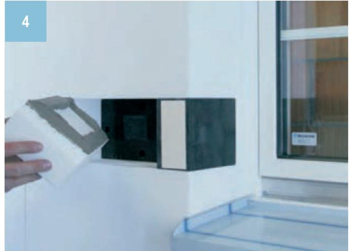
4) Découper la pièce adaptée en panneau isolant afin de combler l'évidement de la plaque, étaler du mortier de collage et presser fort pour revenir à fleur des panneaux.
